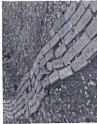
Недопустимо использовать неровное покрытие пешеходных дорожек. Плитка не должна иметь провалов и впадин.
